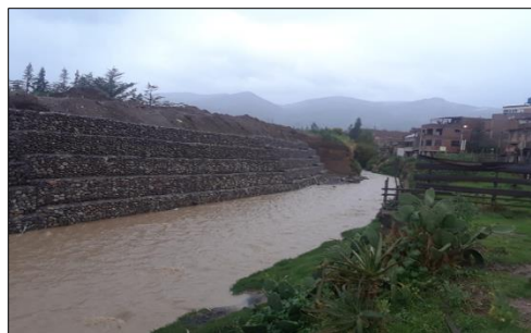
Fotografía N°04: Llenado de gaviones quinto nivel.
